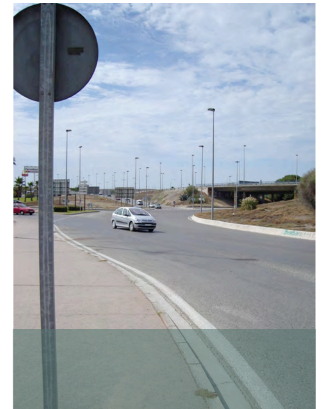
Glorieta de acceso a la N-IV
