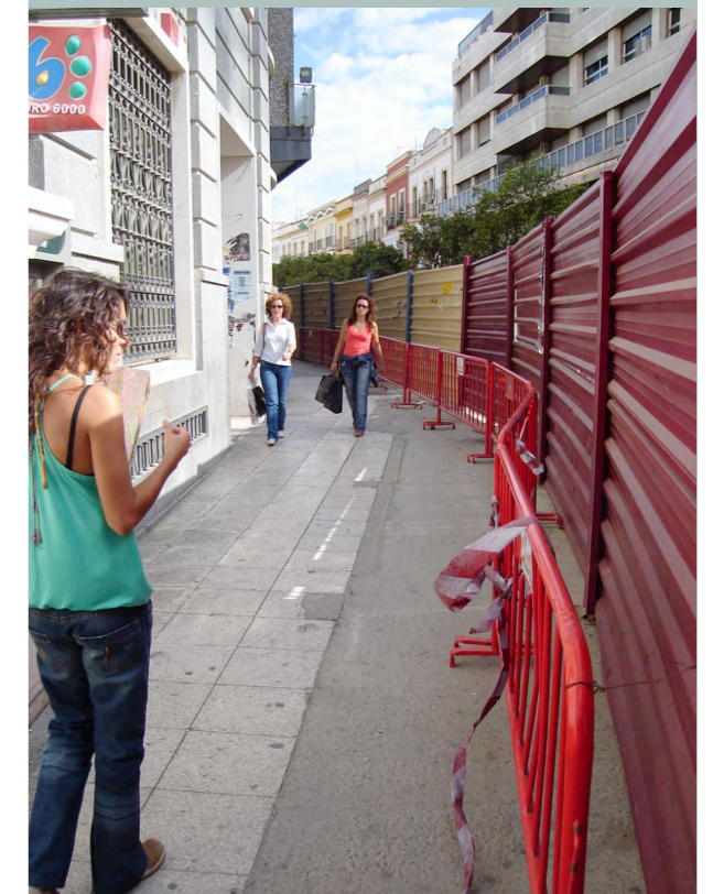
Varias imágenes de las obras en Plaza del Arenal
