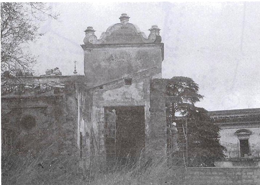
Foto 2.- Torre del molino del Alcázar. Nave de prensa que se desarrolló con fachada al solar del antiguo teatro Eslava. Estado inicial en el momento de acometer los trabajos de investigación. Al fondo bajo la torre de contrapeso se abre la "capilla". A mano izquierda edificación correspondiente a la sala de molienda.
