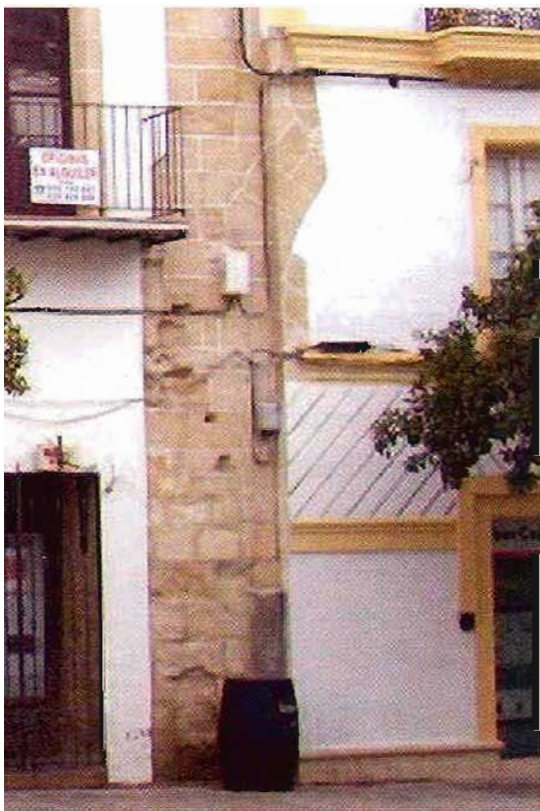
Figura 5. Arranque de arco interior de la Puerta de Sevilla que puede verse en paramentos de las fincas de la plaza de Rafael Rivero.
